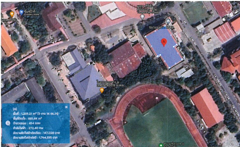
รูปที่ 9 ภาพด้านบนหลังคาอาคารโรงยิมเนเซียม 2
