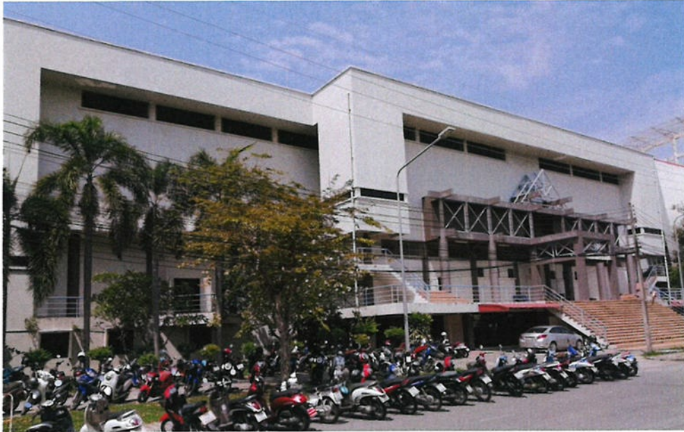
รูปที่ 8 อาคารโรงยิมเนเซียม 2
