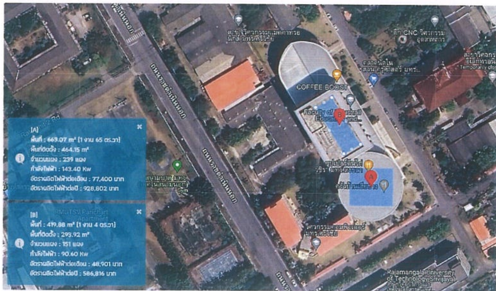
รูปที่ 7 ภาพด้านบนหลังคาอาคารเรียนรวมและปฏิบัติการ คณะวิศวกรรมศาสตร์และเทคโนโลยี
