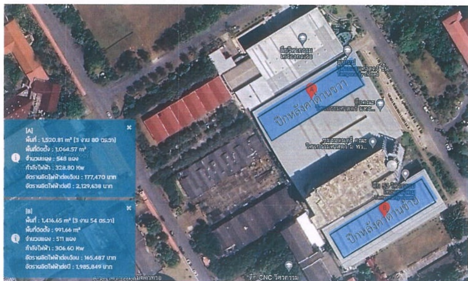
รูปที่ 3 ภาพด้านบนหลังคาอาคารเรียนรวมและปฏิบัติการคณะวิศวกรรมศาสตร์
