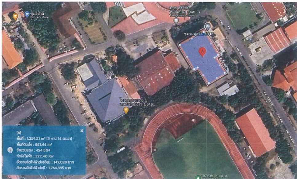
รูปที่ 9 ภาพด้านบนหลังคาอาคารโรงยิมเนเซียม 2
