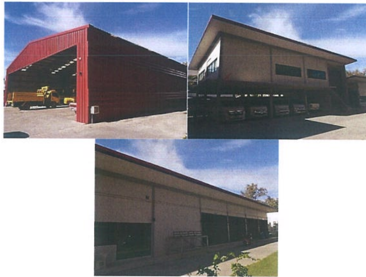
รูปที่ 12 อาคารโรงช่างและโรงจอดรถ
